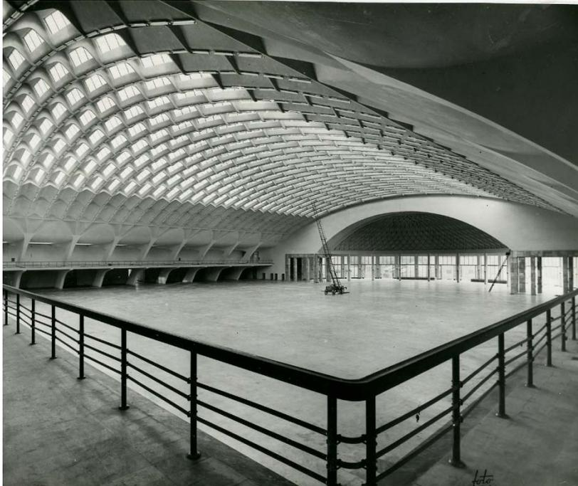
Negli spazi esterni della terrazza il nuovo parapetto riproporrà il disegno di quello esistente, sovrastato da un corrimano tubolare in acciaio e verrà posizionata una rete metallica sempre in acciaio, che garantisca l'inattraversabilità del parapetto (Per gli spazi interni la rete sarà sostituita da pannelli vetrati ed il corrimano sarà invece realizzato in legno, con materiali e criteri rispondenti ai requisiti previsti di solidità e resistenza).
