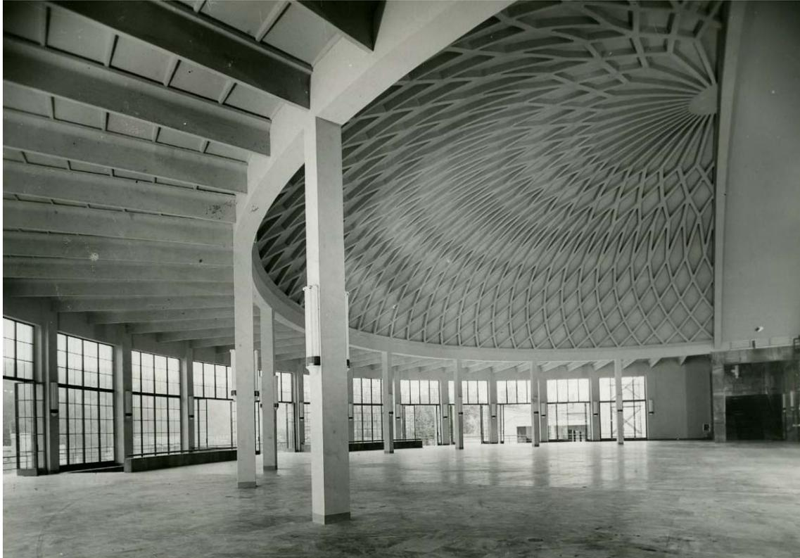
Fotografia storica dell'abside con la partizione originaria dei serramenti metallici ed il sistema di pilastri e travi
