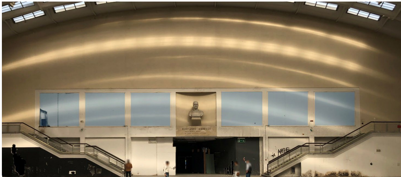
Foto del pad.2 verso ingresso con indicazione delle pannellature che verranno demolite per ripristinare le aperture vetrate.
