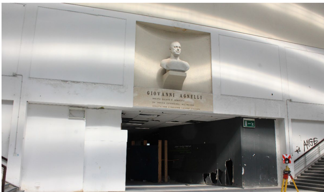
Foto del pad.2 verso ingresso. Ai lati del busto verranno ripristinate le aperture vetrate.
