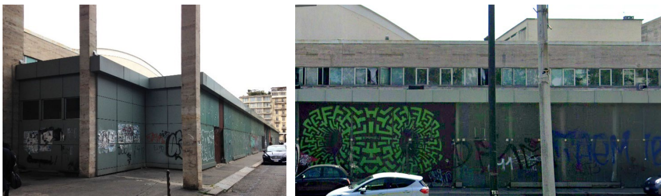
Viste da c.so Massimo d'Azeglio. Avancorpo 2006 e finestratura piano primo
