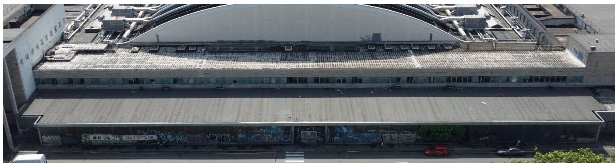
Padiglione 2b ed avancorpo - Copertura
