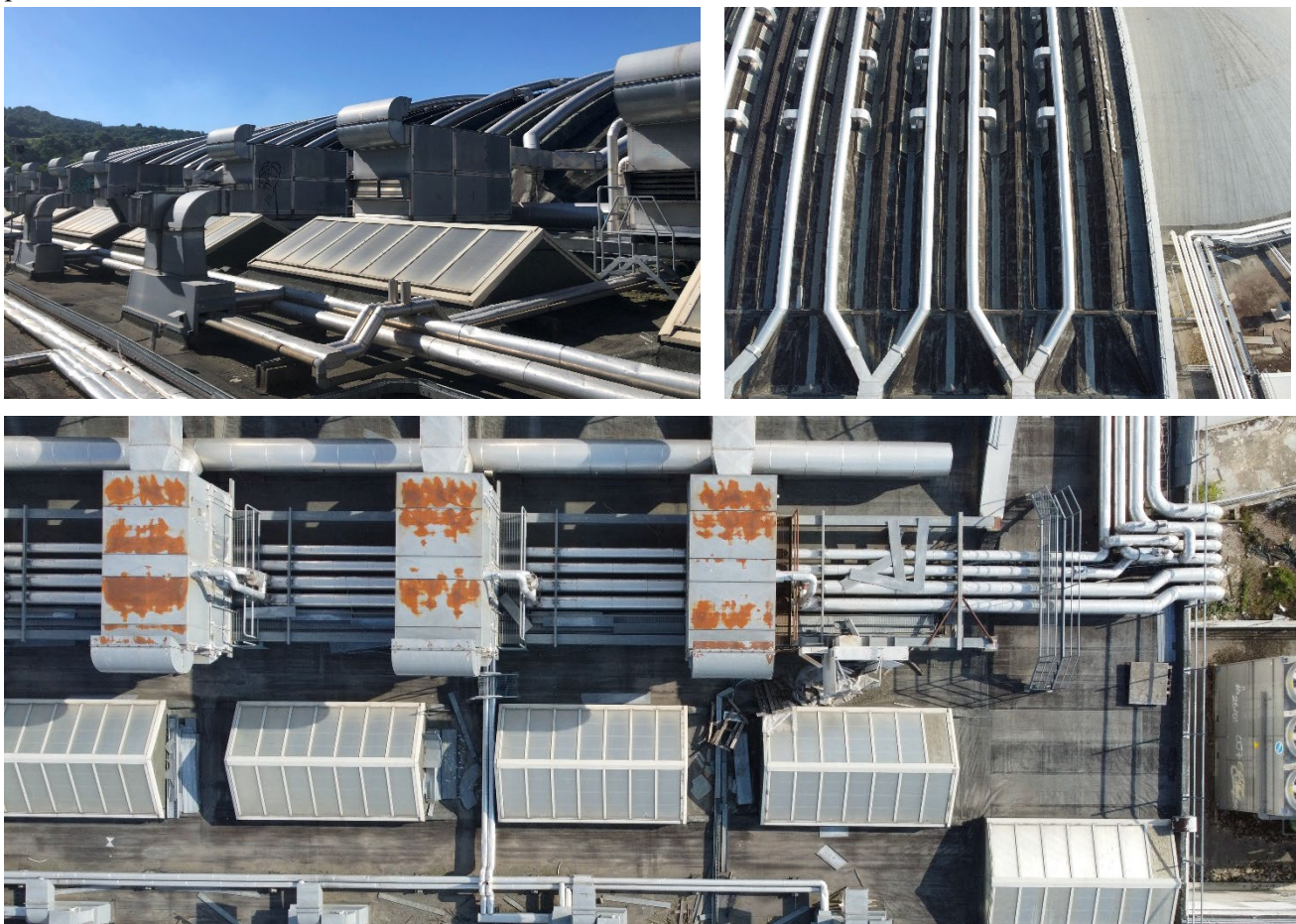
Fotografie della copertura del pad.2
