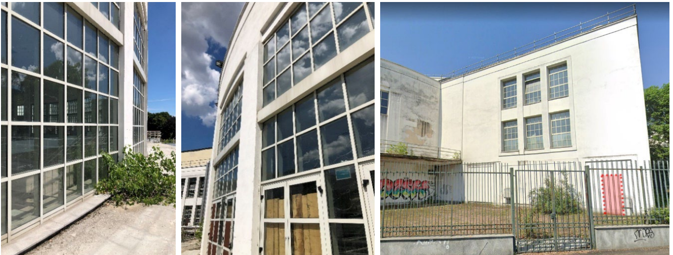
Foto dello stato di fatto: vetrata abside e facciata in cui sarà aperto il varco
