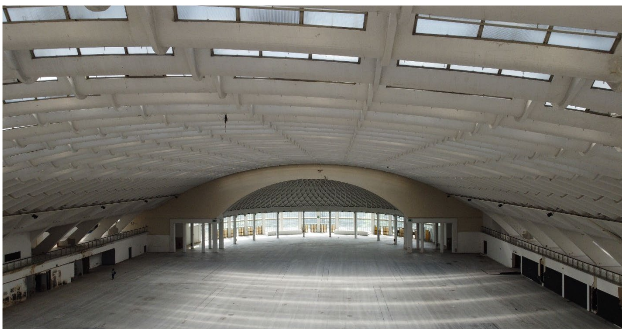
Padiglione 2 - Vista del Salone dall'ingresso principale su c.so Massimo d'Azeglio
