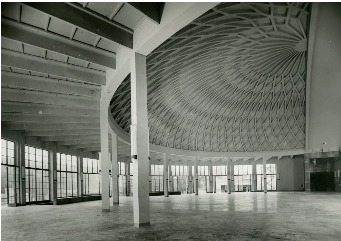
Fotografia storica dell'abside con la ripartizione originaria dei serramenti metallici ed il sistema di pilastri e travi
