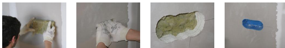
Figura 26 – Partizioni in cartongesso: posa delle scatole elettriche.
