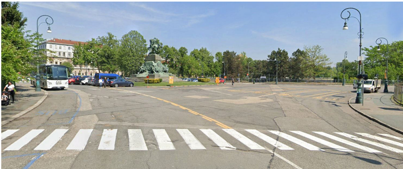
Piazza Rita Levi Montalcini: area a parcheggio in conglomerato bituminoso
