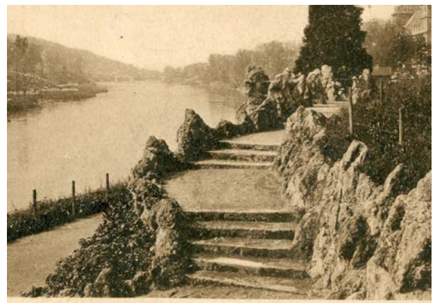
Fig.7 Roccaglie lungo uno dei nuovi affacci
