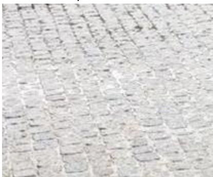
P05 - Pavimentazione in cubetti di diorite chiara piemontese.
