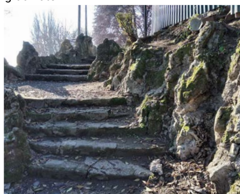
Restauro e messa in sicurezza delle gradinate
