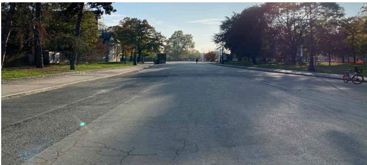
Viale Mattioli: superficie del viale in asfalto, doppio marciapiede laterale, anch'esso asfaltato
