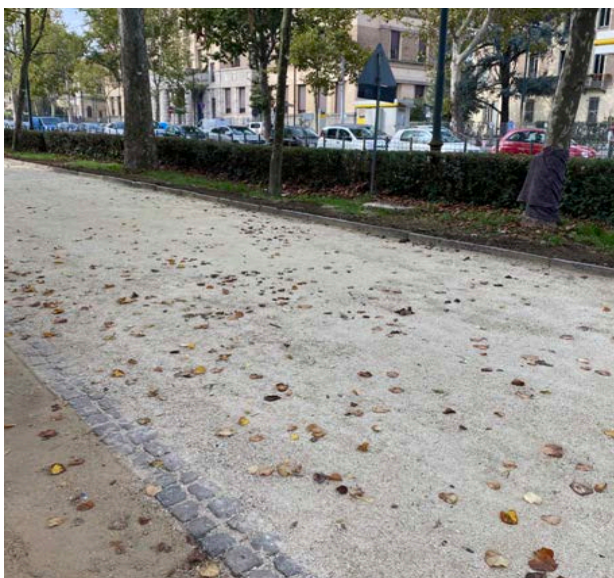
Percorso alberato lungo corso Massimo D'Azeglio in calcestre di nuovo rifacimento
