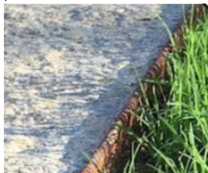
E01 - Nuove aiuole a raso delimitate da profilo in acciaio zincato a raso.
