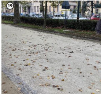
19 Percorso alberato lungo corso Massimo in calcestruzzo
