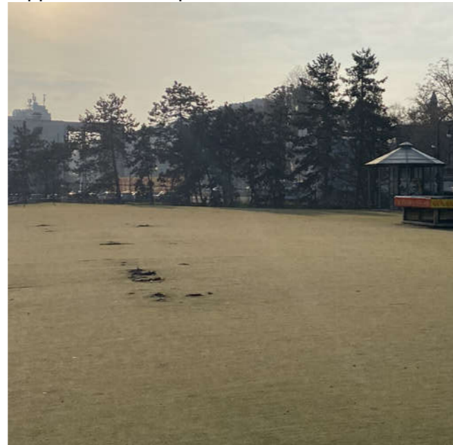
Tappeto sintetico superficiale usurato
