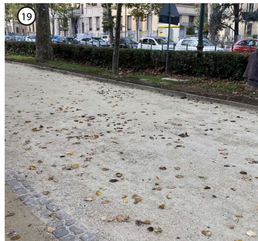
Percorso in calcestre alberato lungo corso Massimo D'Azeglio
