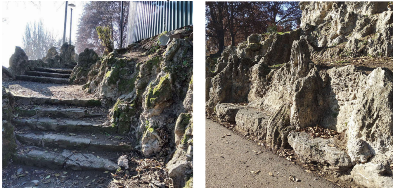
Rocailles costituite da materiale roccioso di origine naturale, ovvero roccia tufacea
