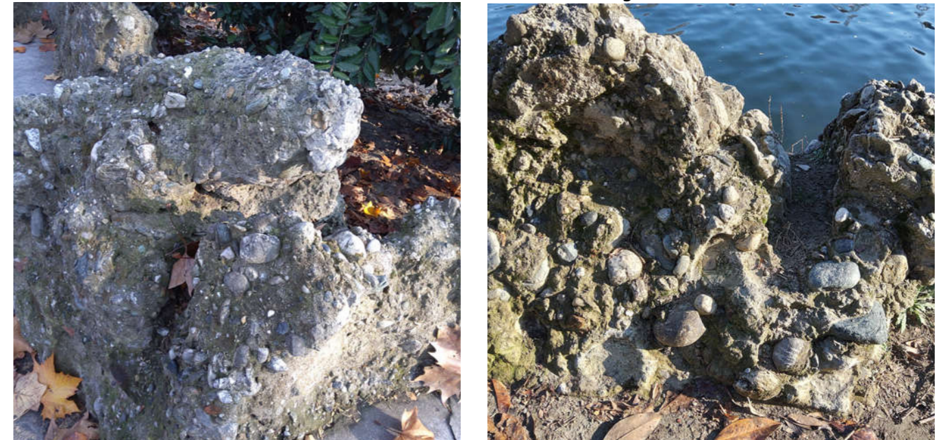
Rocailles in materiale artificiale realizzato ad imitazione della tecnica a roccaglia
