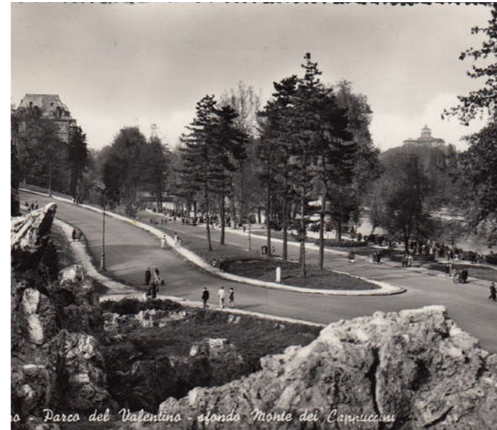
Fig.20_ Vista su viale Crivelli, 1950
