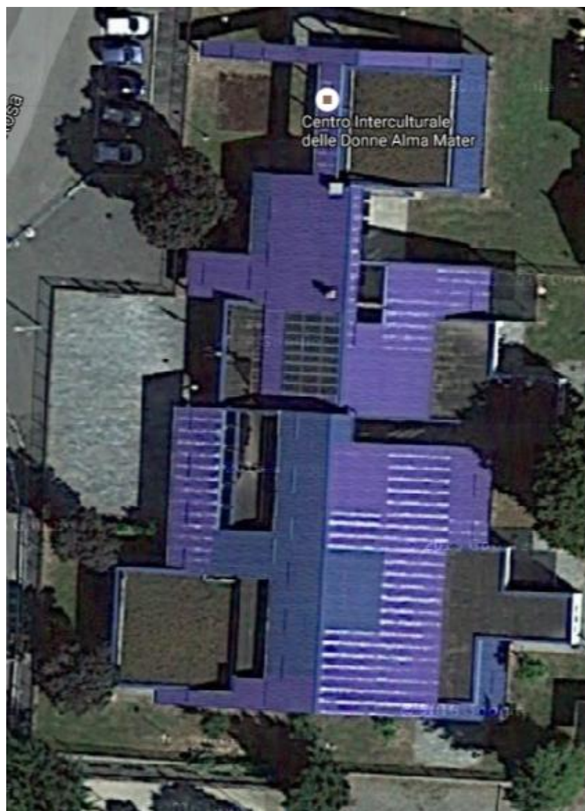
Figura 14 – inquadramento aerofotogrammetrico dell'edificio
