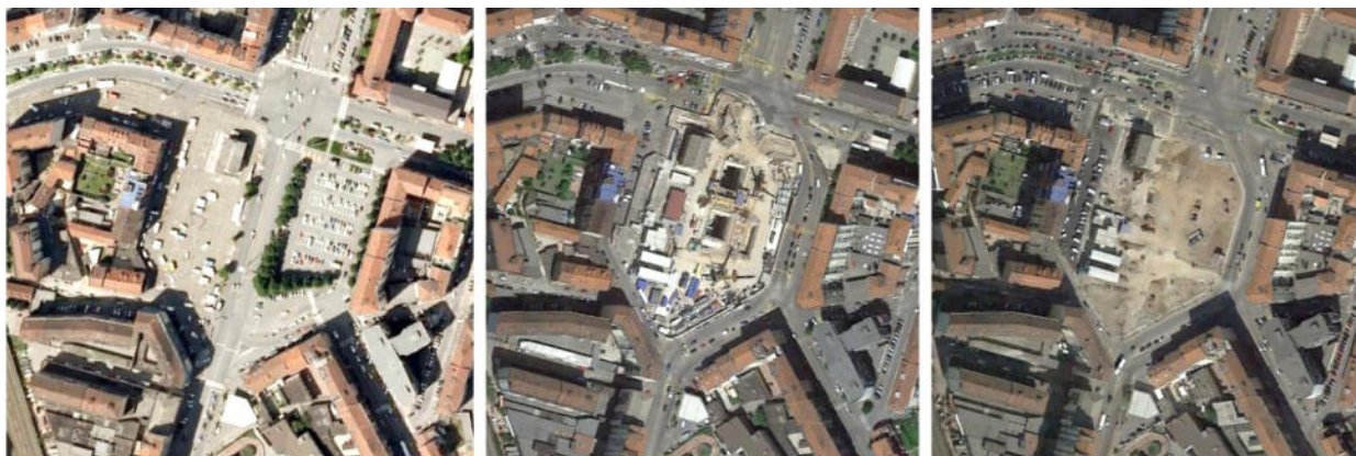
Figura 2 - Rappresentazione dell'area prima (03/2008), durante (08/2016) e dopo (03/2021) i lavori per la realizzazione della nuova fermata della Metropolitana di Torino [fonte Google Earth 2021]
