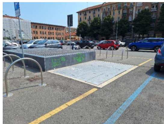
Figura 28 - Griglie di aerazione della stazione Metropolitana
