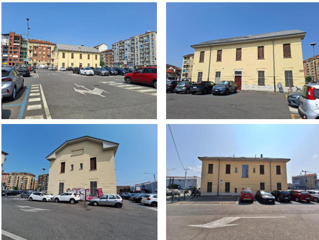
Figura 11 - Edificio daziario da preservare
