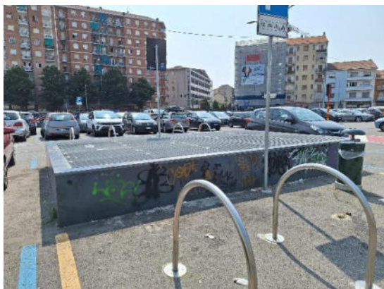
Figura 28 - Griglie di aerazione della stazione Metropolitana
