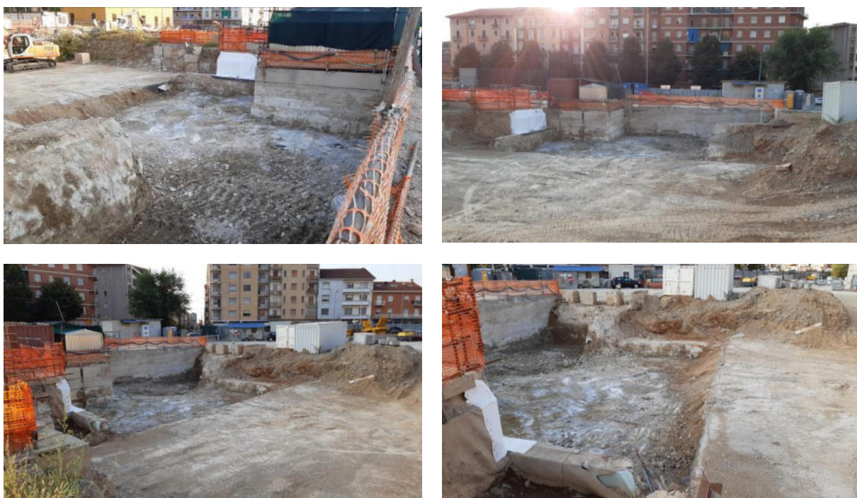
Figura 34 - Rilevo fotografico della vasca di smarino prima dell'interramento
