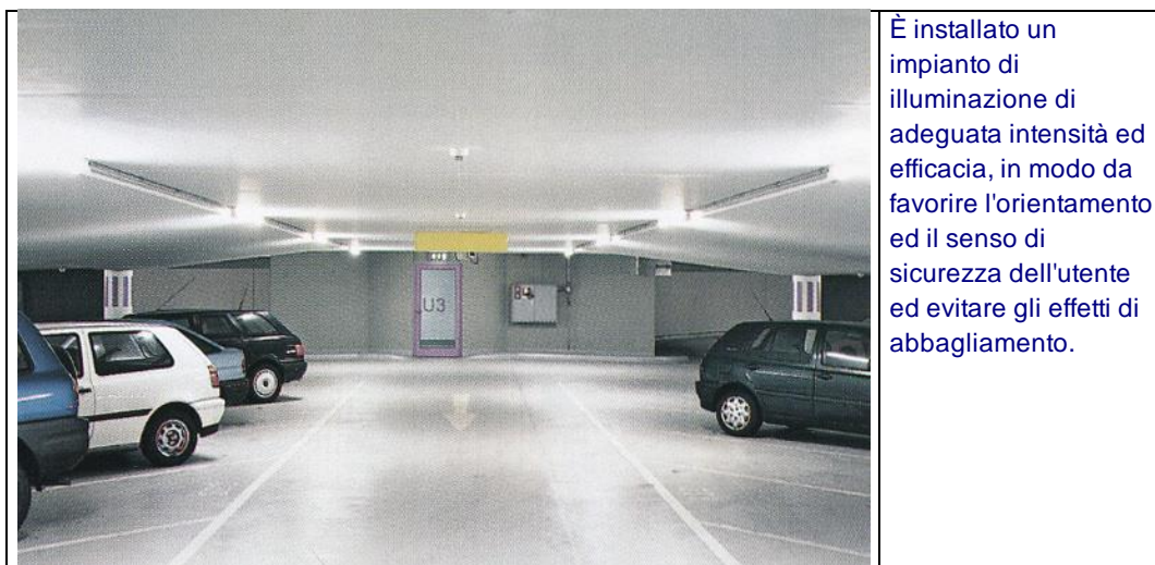
Figura 13 – Esempio di sistema di illuminazione parcheggio interrato.
