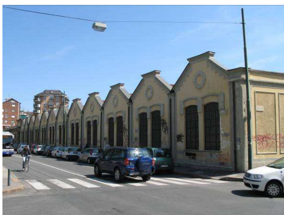
Fronte su via Frejus
