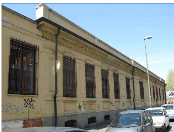
Fronte della palazzina uffici su via Cesana
