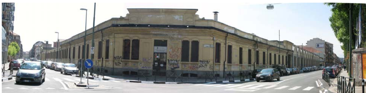
La palazzina uffici in cessione al Comune, posta su impronta dell'impianto originario all'angolo tra le vie Frejus e Cesana, ma anch'essa oggetto di successivi interventi di sopraelevazione e di modifica delle decorazioni.
