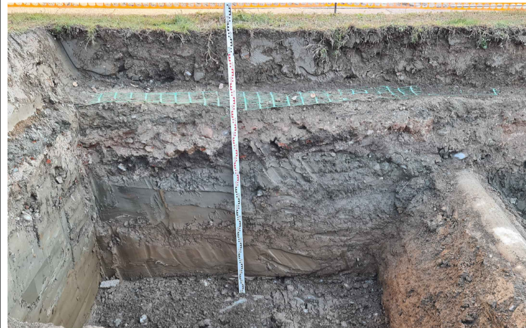
Verona 5 - Area a termine scavo, da ovest
