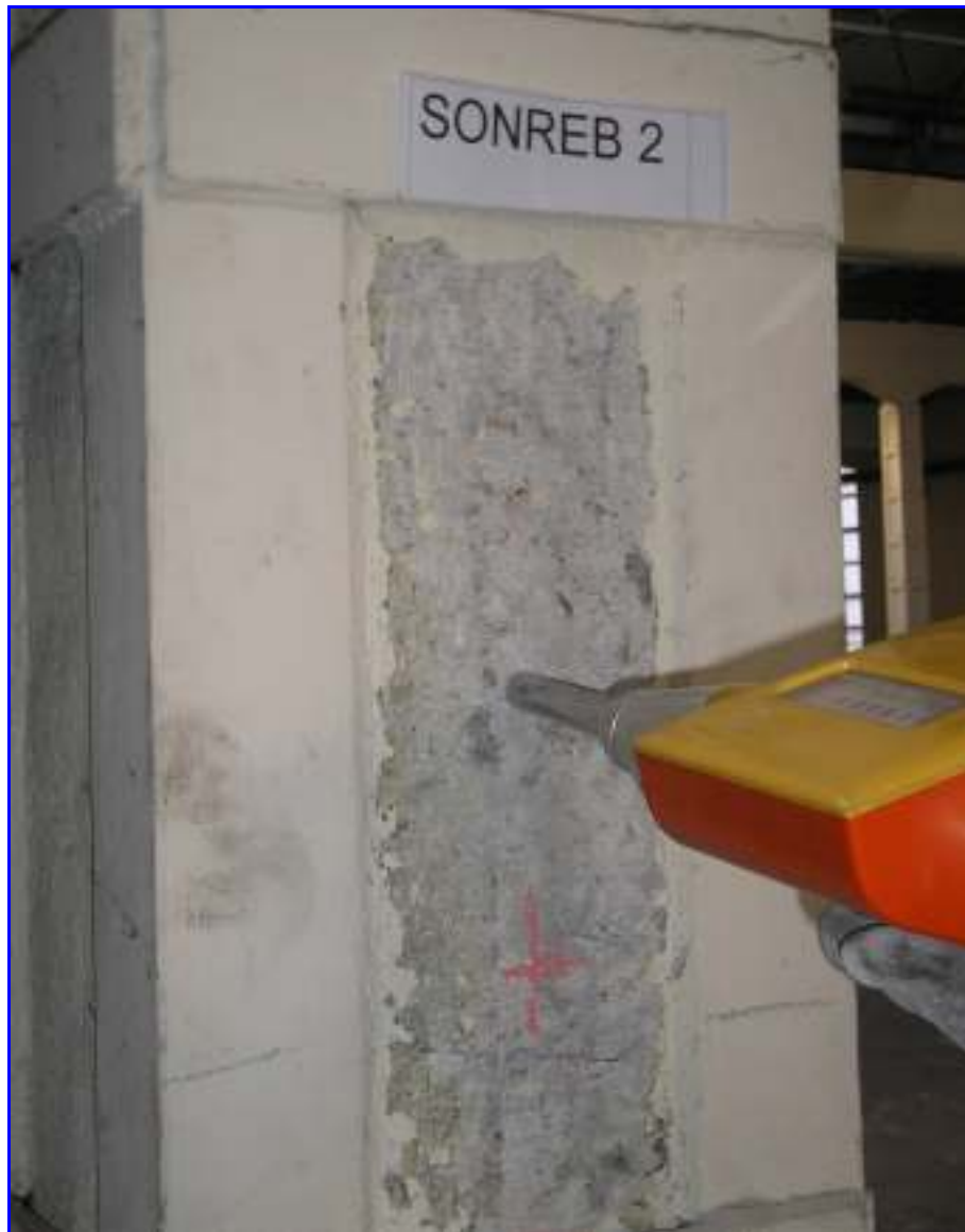
Le battute sclerometriche sul pilastro 2
