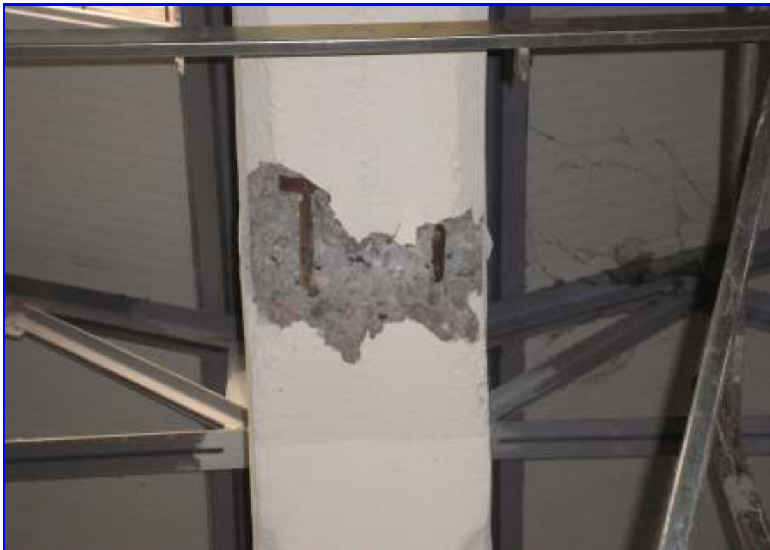
Particolare del sondaggio in corrispondenza dell'appoggio
