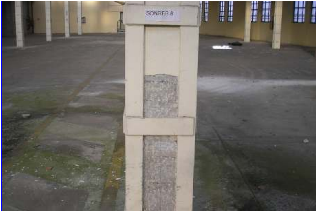
Vista del pilastro n°8
