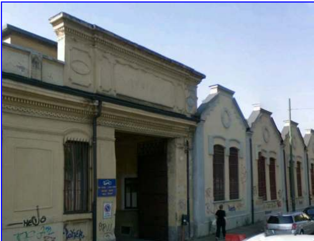
Panoramica del fabbricato
