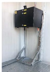
Serbatoio gasolio doppia parete installato separatamente dalla motopompa su apposito supporto in acciaio zincato e già collegato al motore Diesel
