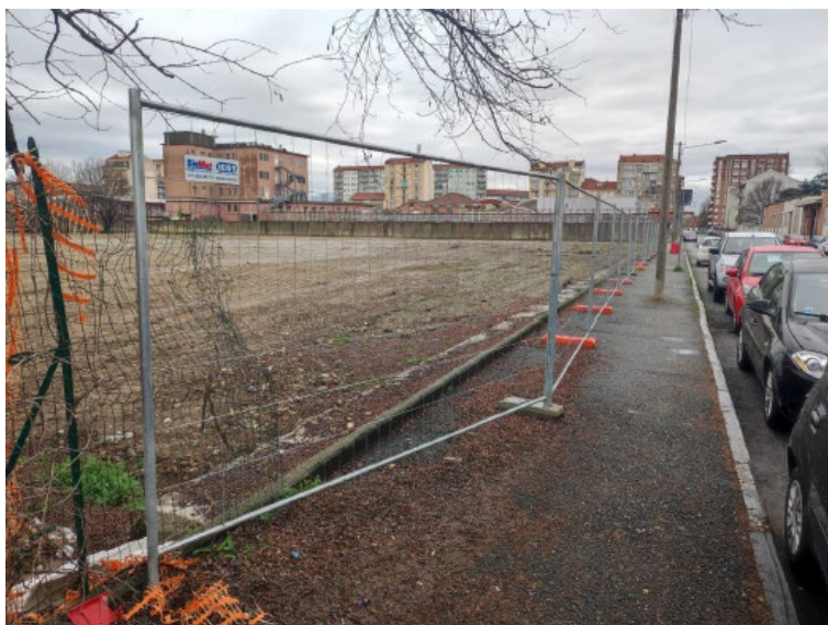
Fig. 2: vista via Reycend pre-pulizia su area di intervento
