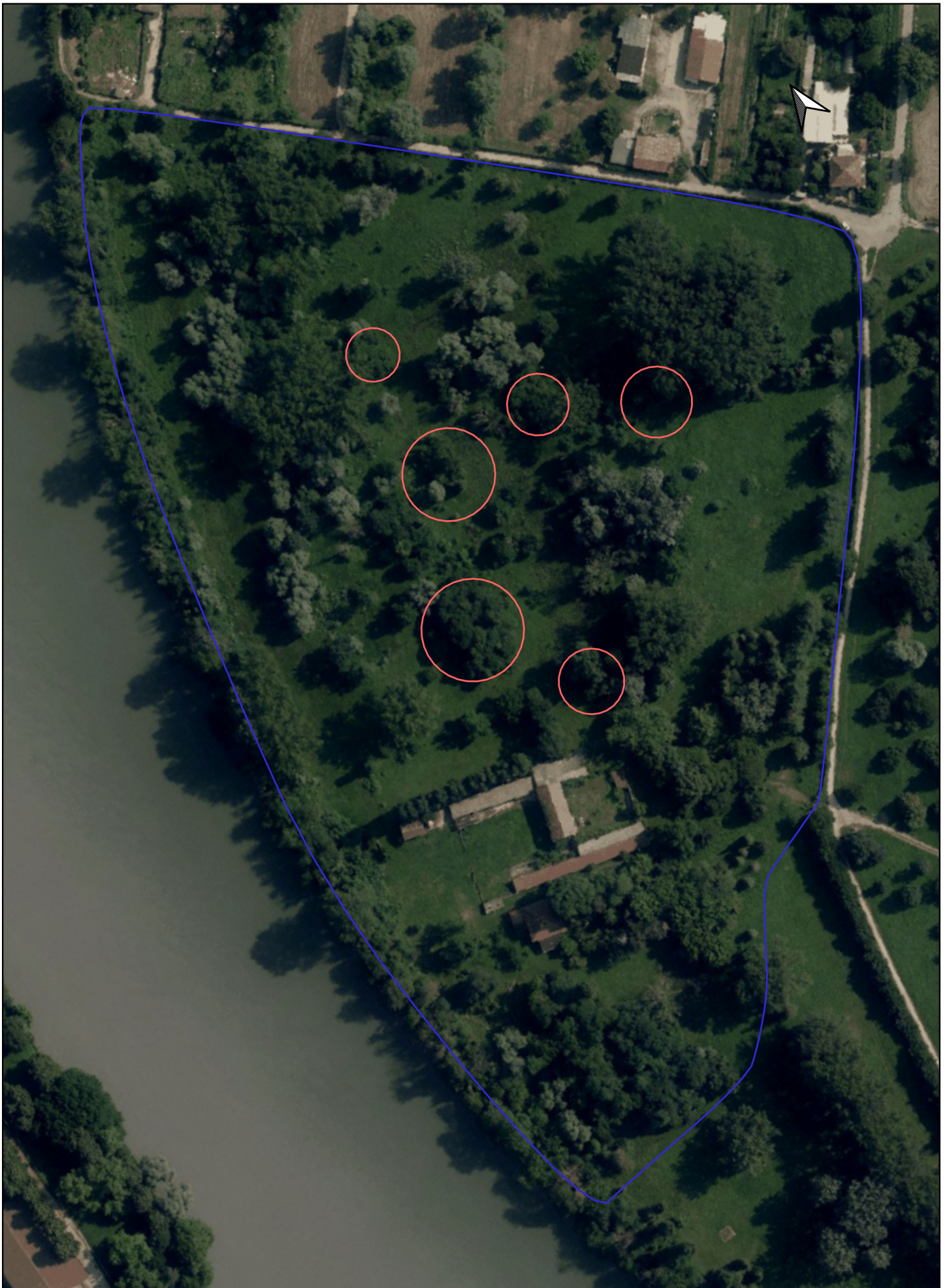
AREA DI INDAGINE DELLA RELAZIONE FORESTALE: Ortofoto 2018 del Comune di Torino, scala 1:2000
