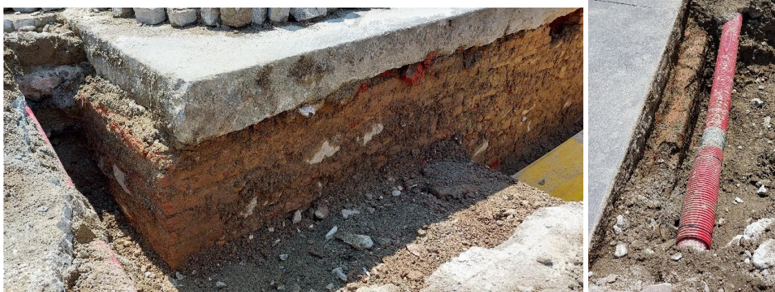
Fig. 2 (foto n. 30, a sinistra). Ampliamento del saggio nord, vista della fondazione del monumento, da nordovest.
