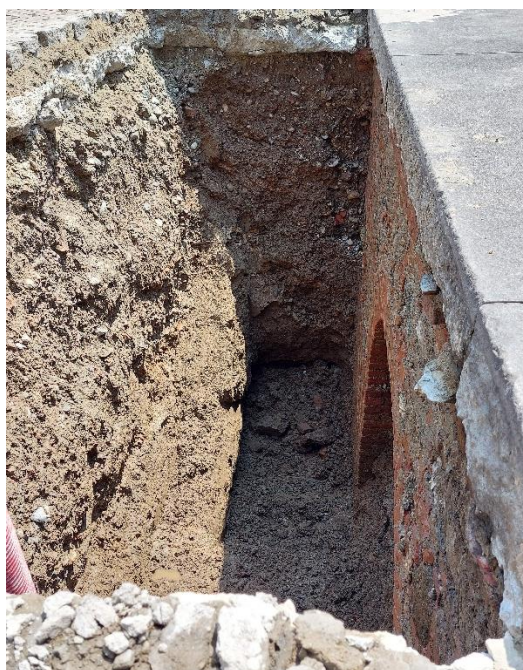
Fig. 4 (foto n. 16). Saggio nord, sezione est con cavo di fondazione, vista da ovest.
