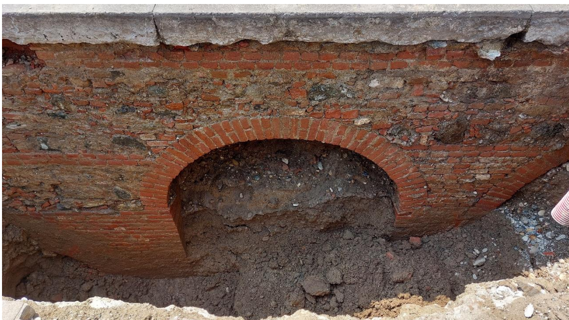
Fig. 1 (foto n. 20). Saggio nord, fondazione del monumento, vista da nordovest.
