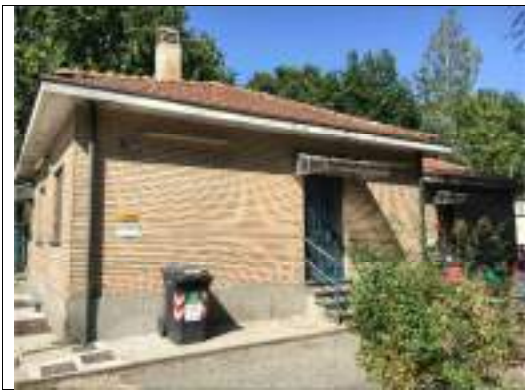
Foto esterna palazzina uffici
