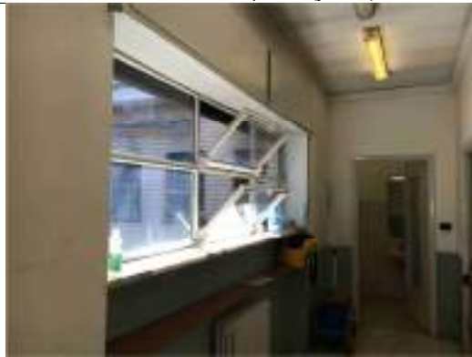
Foto interna corridoio uffici
