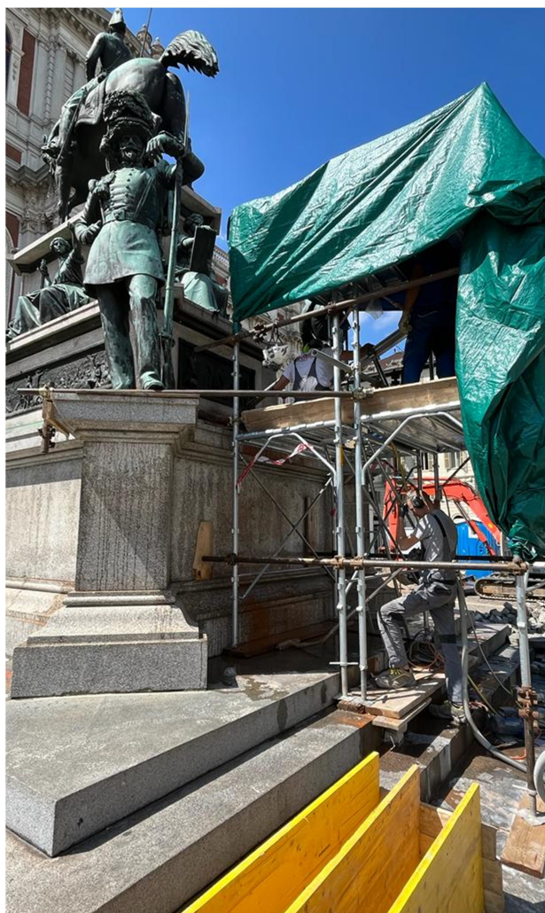
Foto 7. Esecuzione carotaggio n. 2
