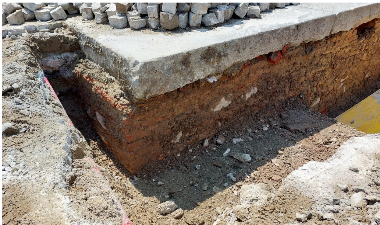
Foto 6. Dettaglio fondazione – sondaggio n. 1
