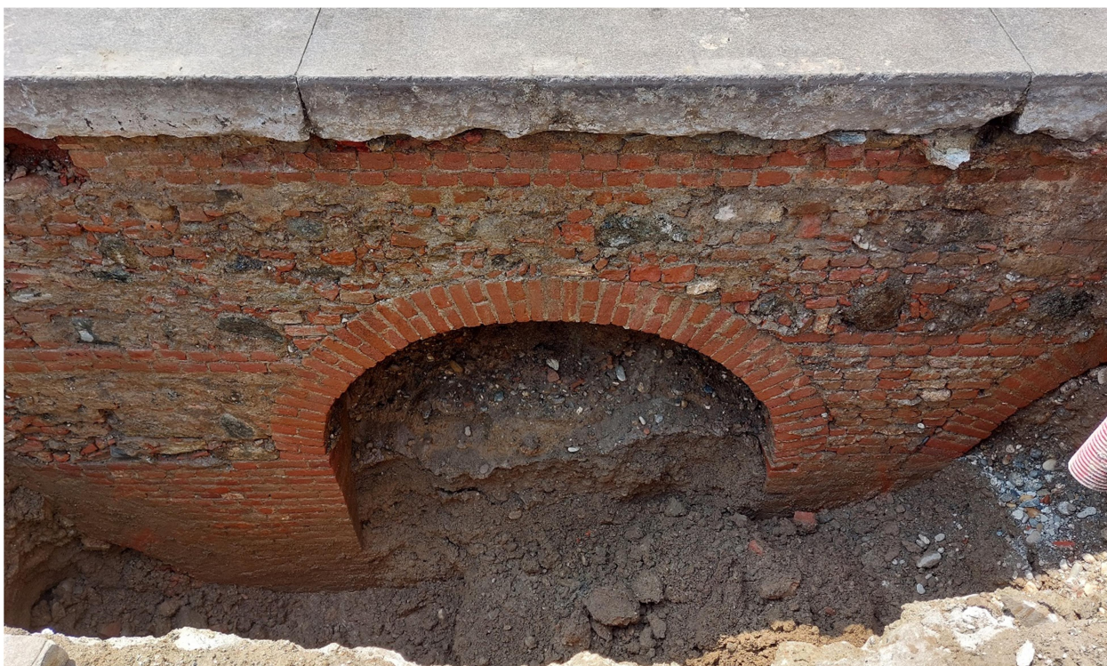
Foto 5. Dettaglio fondazione – sondaggio n.1
