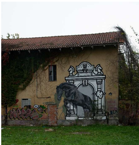
Affresco su edificio principale, foto da sopralluogo
