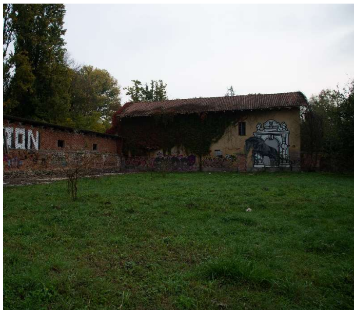
Facciata verso il fiume, foto da sopralluogo
