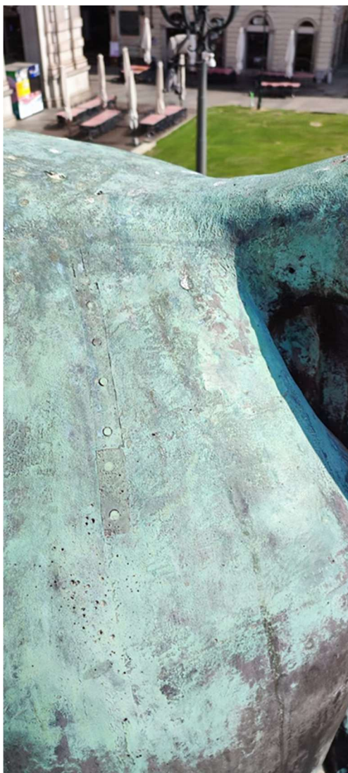
Difetto di fusione e riparazione dello stesso con aggiunta di tasselli in materiale bronzo
