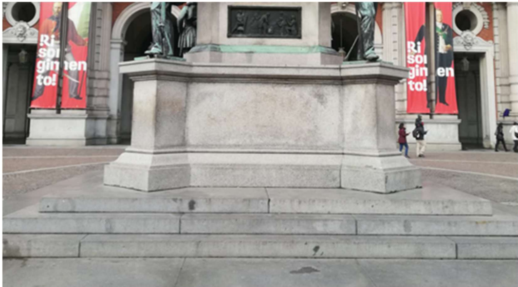
Basamento lapideo: blocco inferiore e pavimento a gradoni
