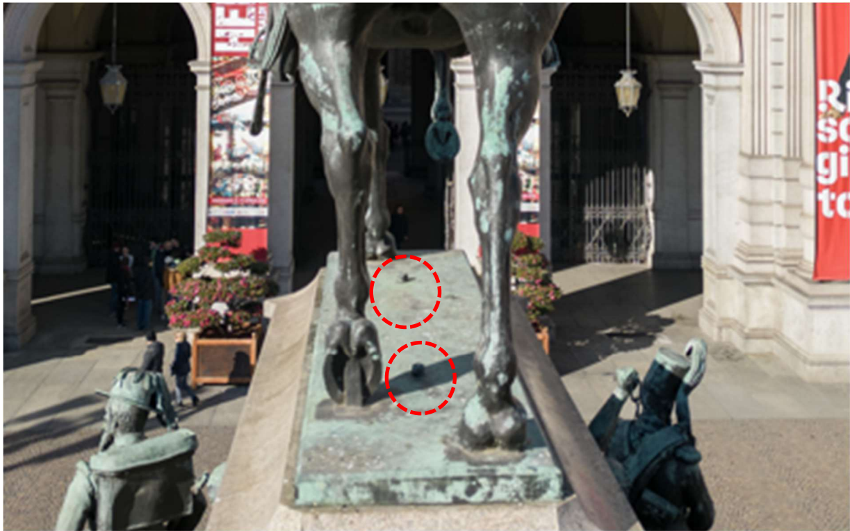
Base del cavallo in bronzo e sistema di ancoraggio al basamento lapideo mediante viti filettate e bulloni
