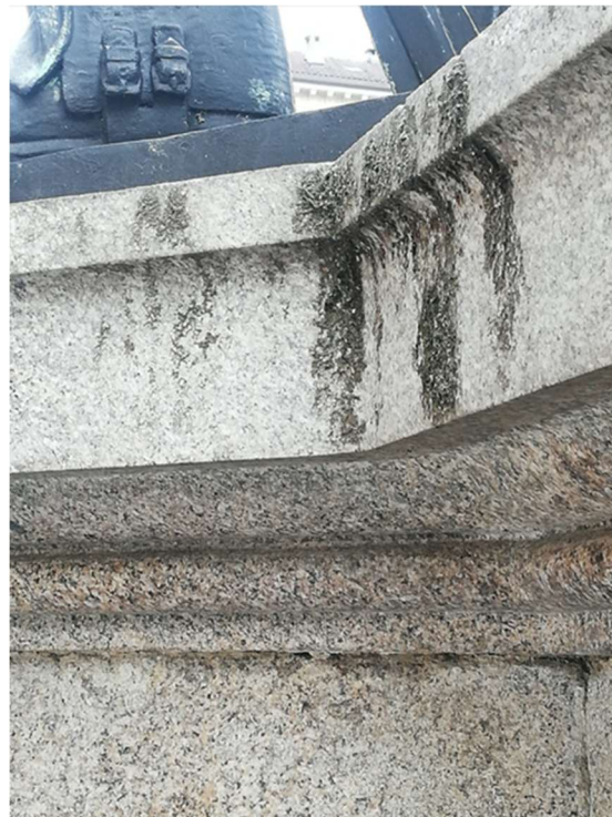
A destra: particolare del gradino: mancanza di materiale causato da danno antropico
