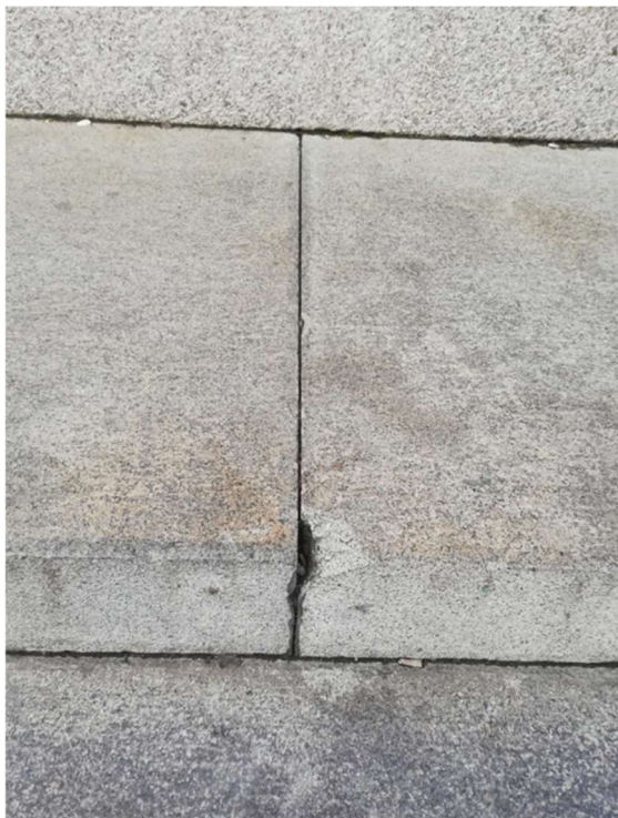
A destra: particolare del gradino: mancanza di materiale causato da danno antropico
