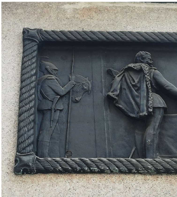
Particolare dell'ancoraggio del bassorilievo al materiale lapideo per mezzo di "placchette" bronzee
