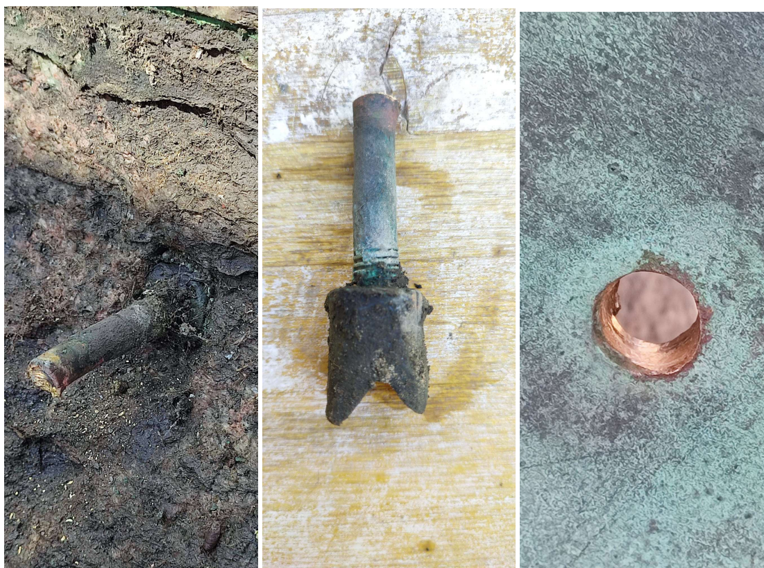
Elementi di fissaggio delle cornici in bronzo al basamento lapideo
