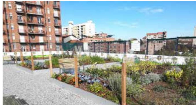
Orti urbani sui tetti in via Bologna, Torino
