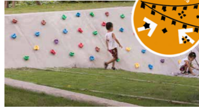
Parete di arrampicata in cls
