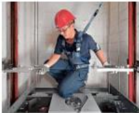
1 Tetto della cabina
