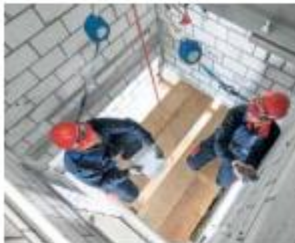
2 Ponteggio per il vano ascensore
