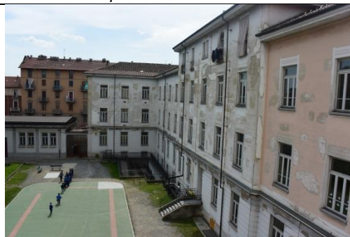
Prospetto cortile interno
