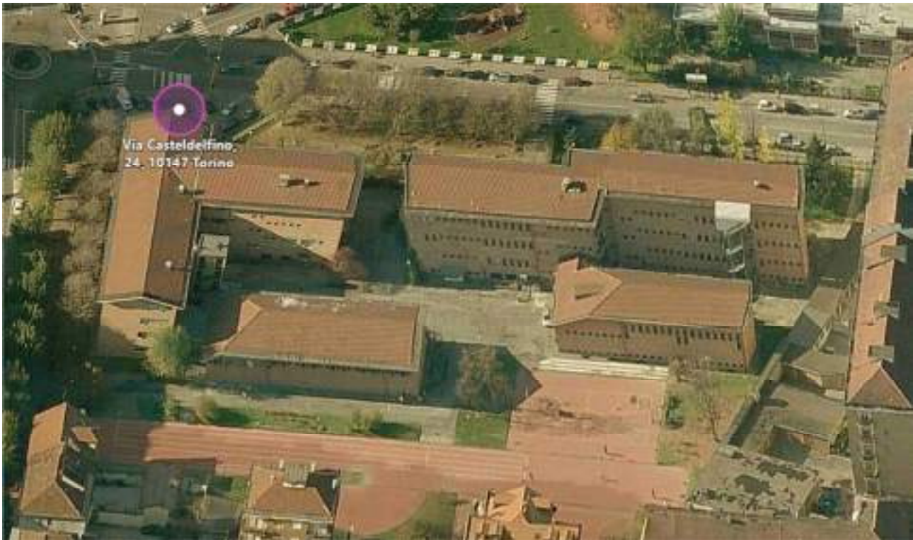
Figura 2 - Vista aerea dell'edificio oggetto di analisi
