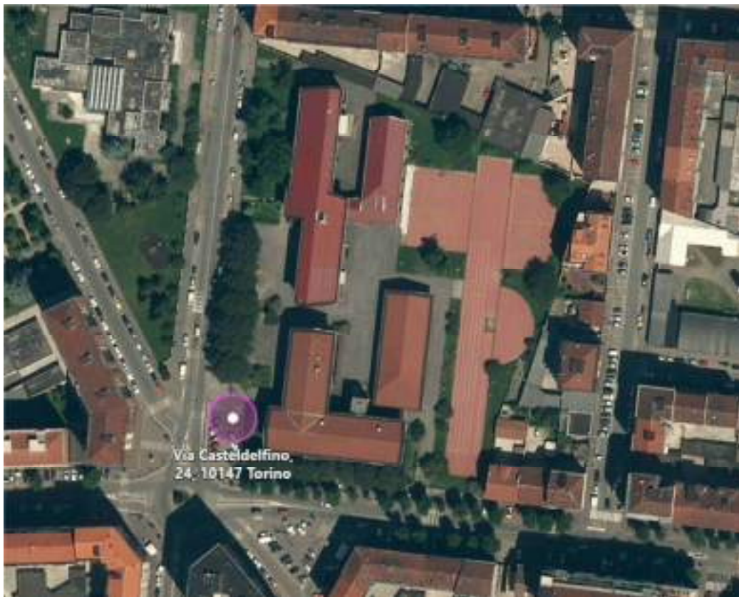
Figura 14 – inquadramento aerofotogrammetrico dell'edificio
