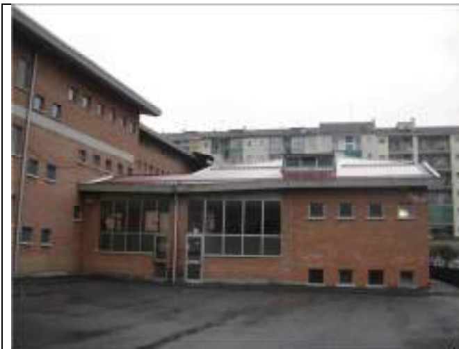
Foto esterna lato cortile
