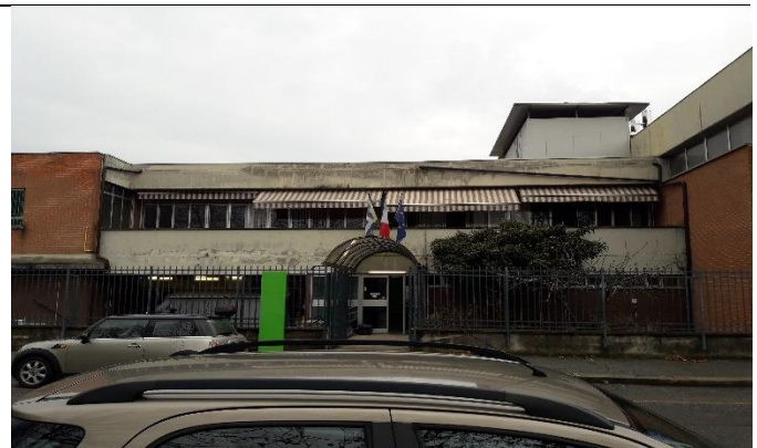
Prospetto principale via Ragazzoni
