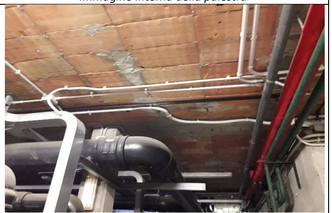
Dettaglio dei solai su interrato non riscaldato
