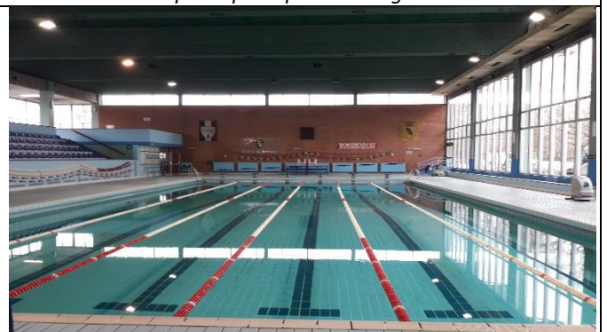
Immagine interna della piscina
