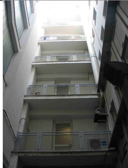
Foto esterna – lato cortile
