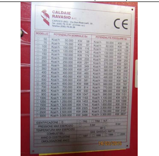
Targa generatore di calore
