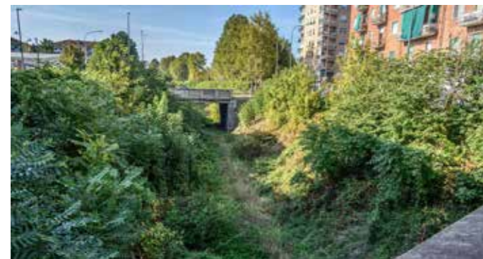
Trincerone tra via Gottardo e via Sempione
