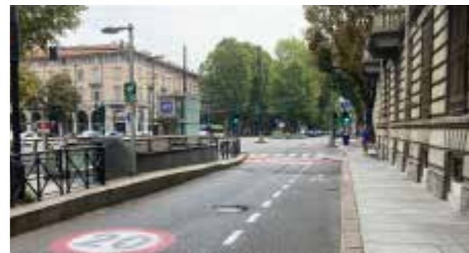
Controviale condiviso, Torino
