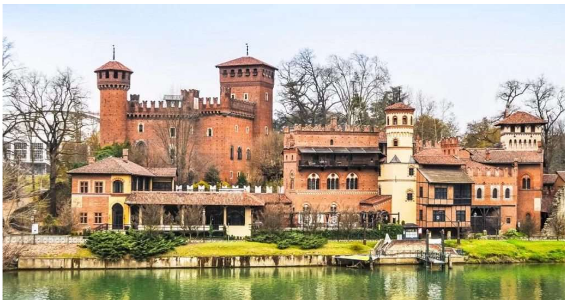
Figura 1 - Vista del Borgo
