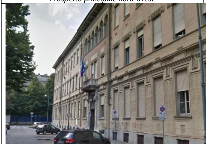
Prospetto sud-ovest, ingresso Circoscrizione 1
