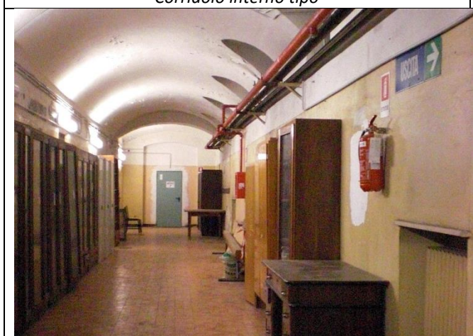
Corridoio seminterrato, archivi
