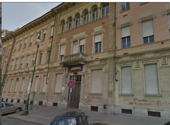
Prospetto nord-est, ingresso Istituto Bosso-Monti
