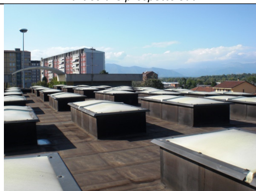
Copertura lucernari palestra
