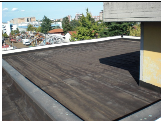
Particolare copertura Primo Livello
