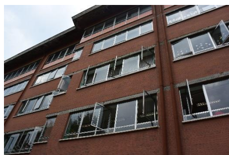
Particolare Prospetto Sud
