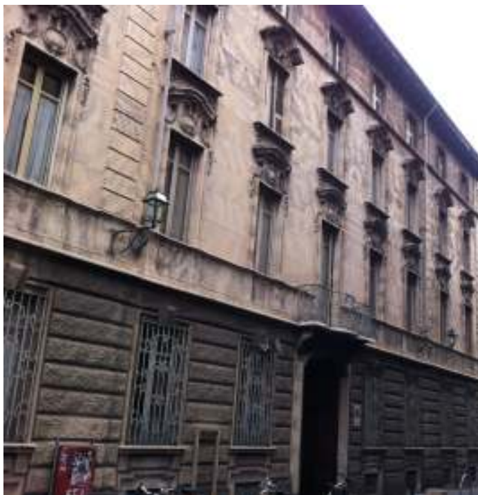
3 Torino, via Barbaroux n. 30. Fronte principale.
