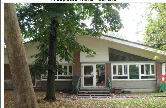
Prospetto Est – verso Via Ancina
