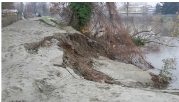
Meccanismo di collasso della sponda fig. 1
