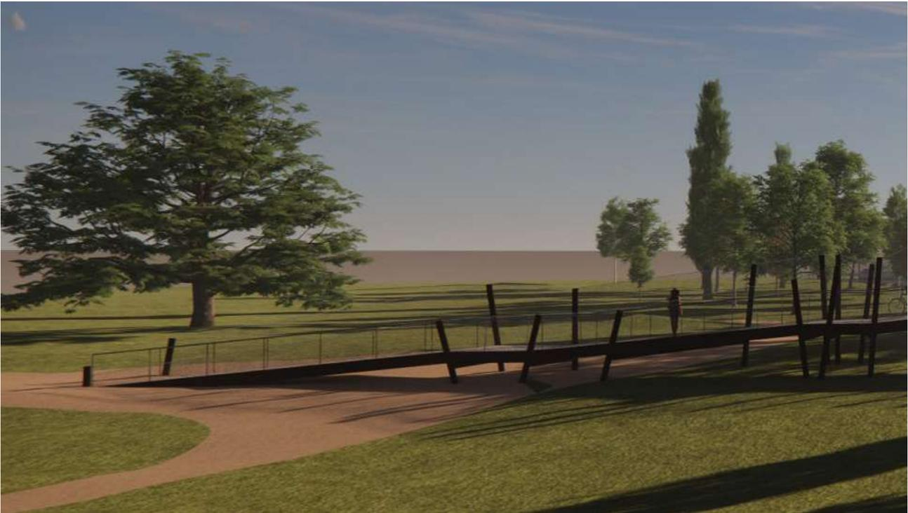
Il numero di elementi metallici di appoggio è almeno in parte compensato dall'abbattimento delle specie arboree instabili o alloctone. Si fa notare che degli oltre 200 m lineari di passerella solo una dozzina di metri sono a rischio allagamento.
