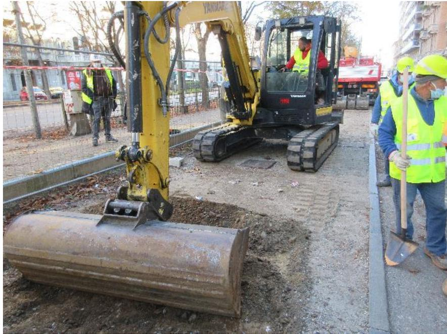
**Figura 3. Uno degli escavatori utilizzati, dotato di benna liscia**
