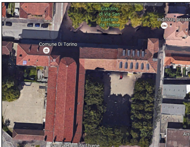
Inquadramento generale – foto aerea
