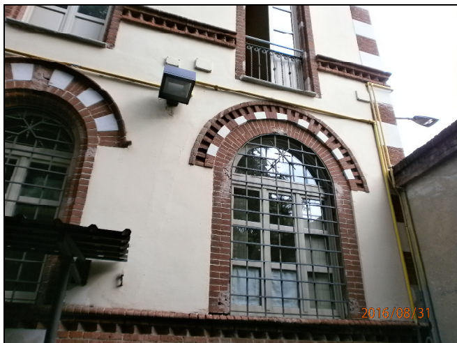
Particolare serramenti (esterno)
