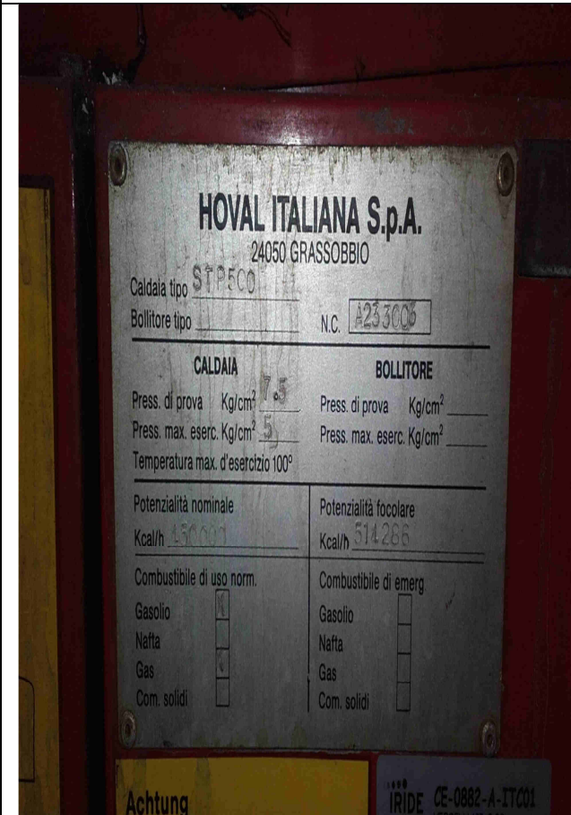
Targa generatore di calore 1
