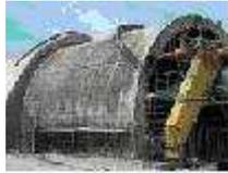
Struttura autoportante in metallo, dotata di carro portaforme di tipo a portale con gambe telescopiche e trave longitudinale rettangolare scatolata per la traslazione su binario. La struttura è munita di pistoni idraulici per sollevamento e/o abbassamento delle forme, sistema di distribuzione del cls, vibratori ad aria compressa alimentati dalla rete presente in galleria e derivata sulla macchina da collettori.
