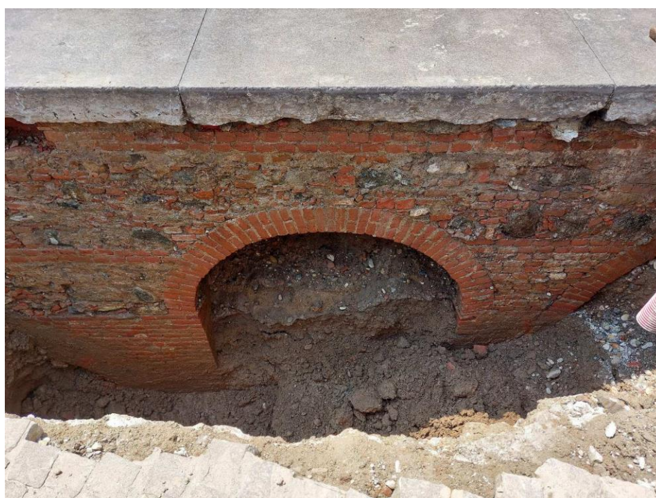
Figura 123. Pozzo n.1 – particolare fondazione rinvenuta durante le indagini
