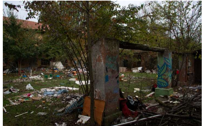
Tettoia da demolire, foto da sopralluogo
