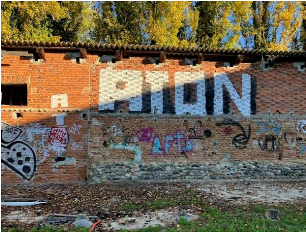
Dettagli delle murature, foto da sopralluogo
