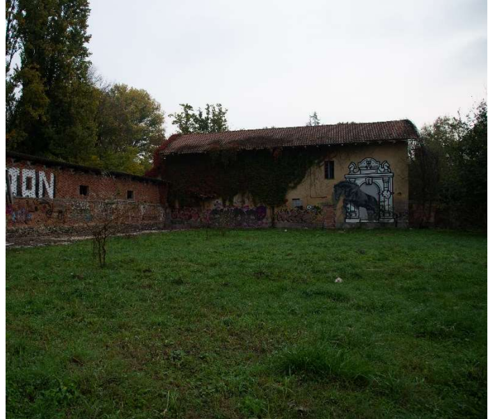
Facciata verso il fiume, foto da sopralluogo
