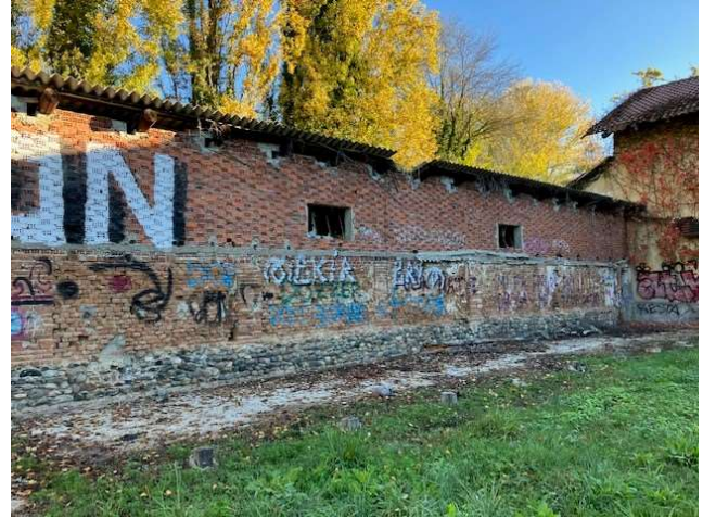
Dettagli delle murature, foto da sopralluogo
