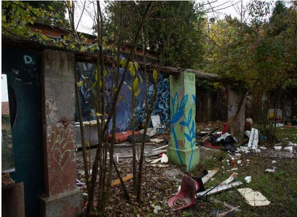
Tettoia da demolire, foto da sopralluogo
