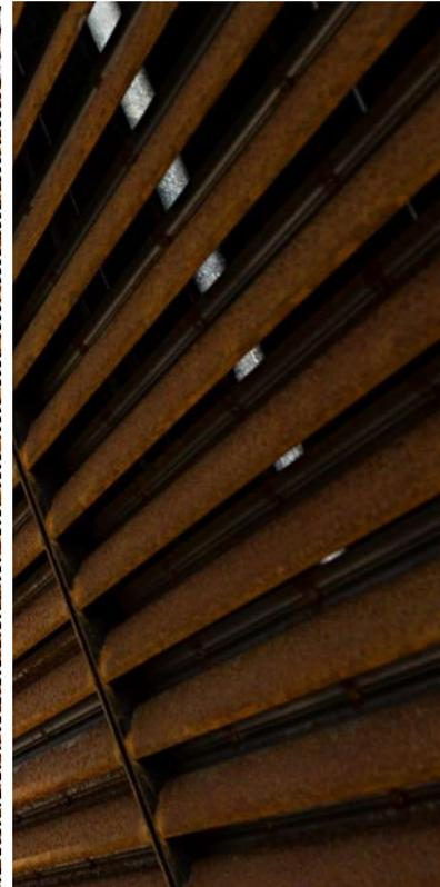
*Acciaio Cor-Ten in lamelle orientate*
