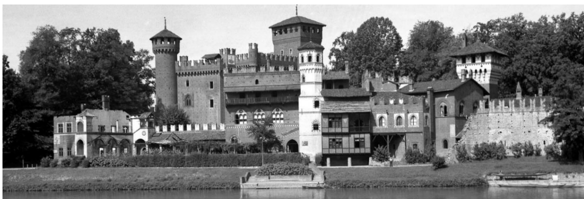
I danni bellici visi dal fiume: La copertura della casa di Ozegna è completamente distrutta
