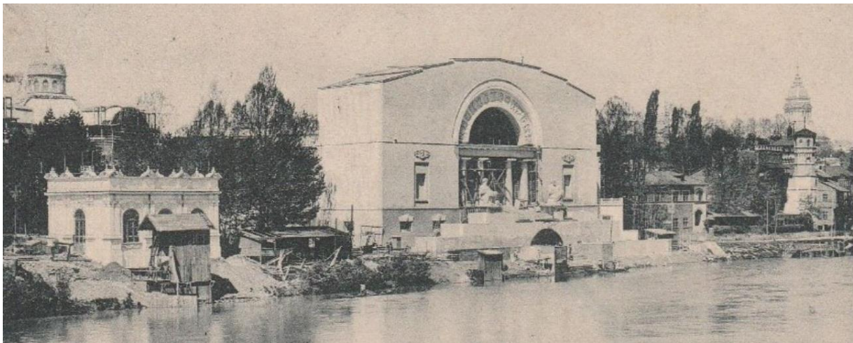
Il padiglione russo in costruzione
