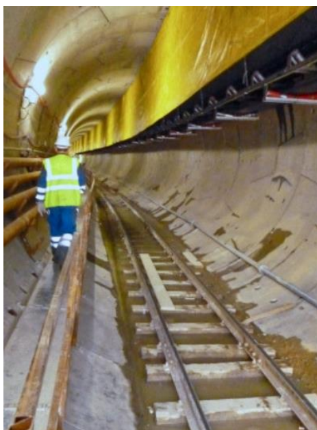
Figura 20. Sistemi di trasporto dello smarino (nastri trasportatori, vagoni).
