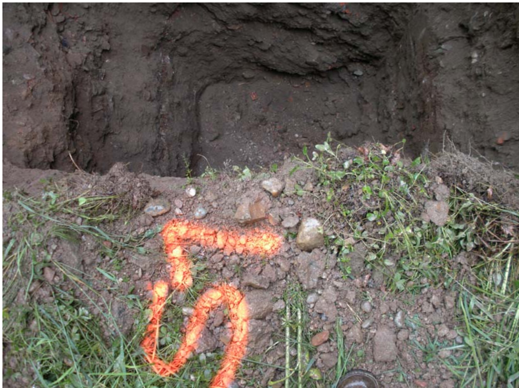
Pozzetto esplorativo S1
