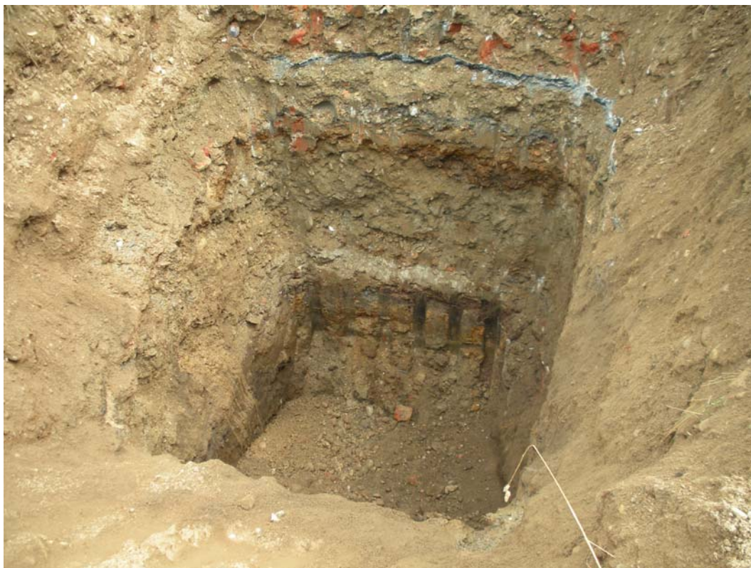
Pozzetto esplorativo S3
