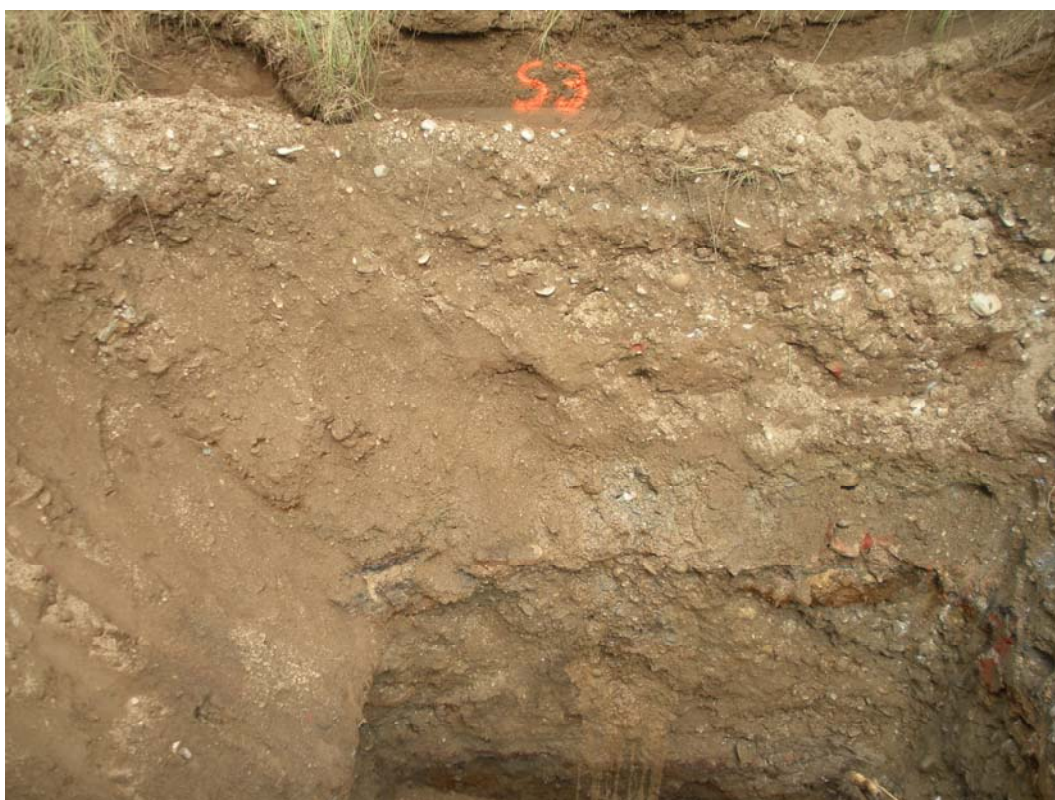
Pozzetto esplorativo S3
