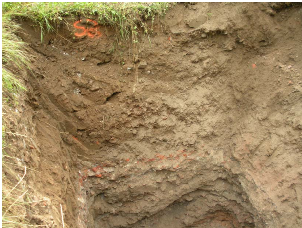
Pozzetto esplorativo S2
