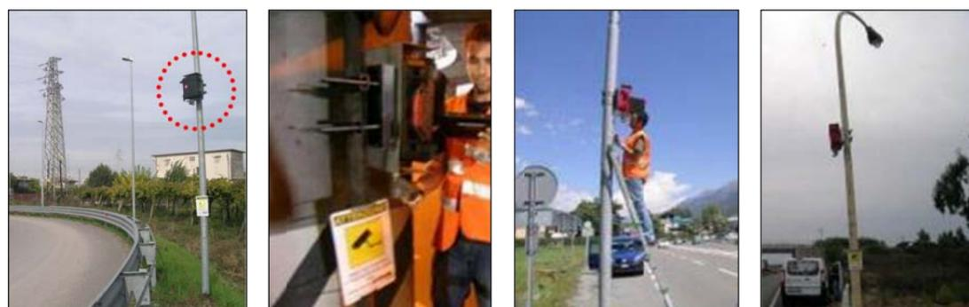
All'interno di tale box sono posizionati la batteria ed un videoregistratore tecnologicamente avanzato, di dimensioni estremamente ridotte, il quale salva i dati filmati su schede SD.
