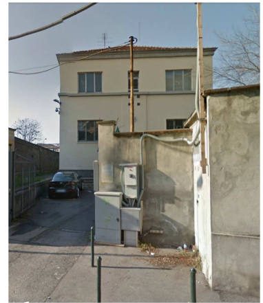
Stazione PolFerr di via Lugaro
