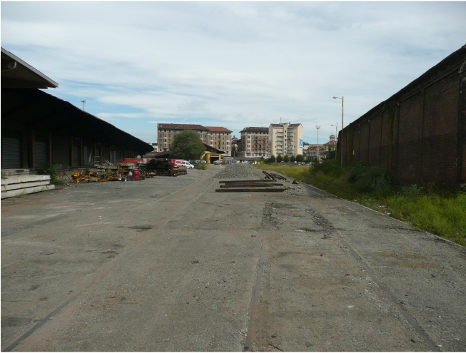
Ai lati capannoni in disuso e vista degli edifici su corso Sommeiller
