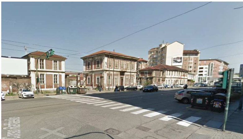
Vista fabbricati minori su Via Nizza
