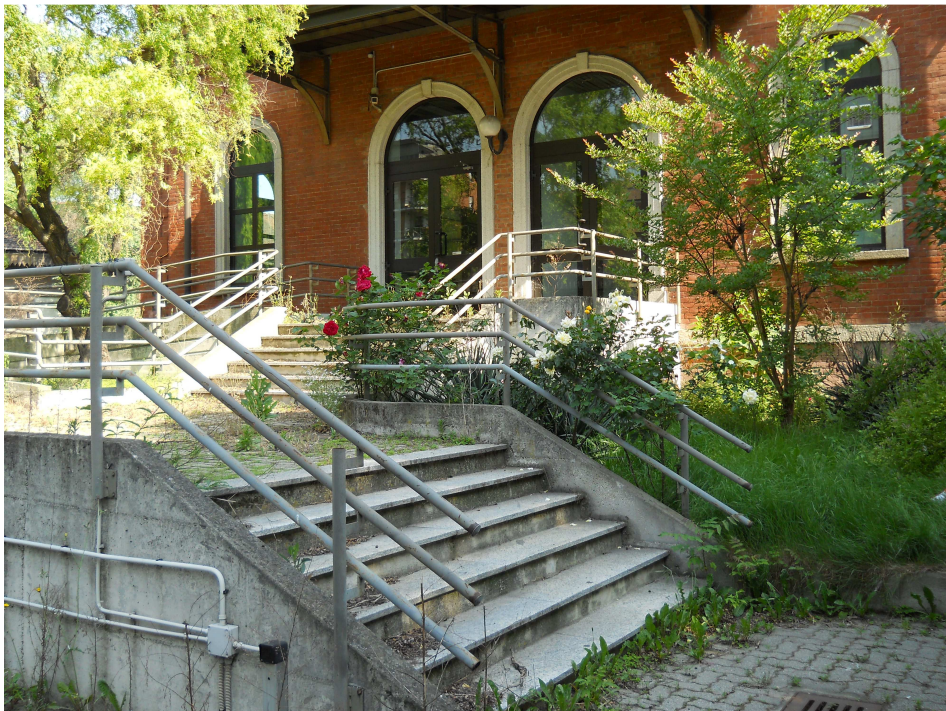
Edificio tutelato, particolare della scala di accesso lato sud
