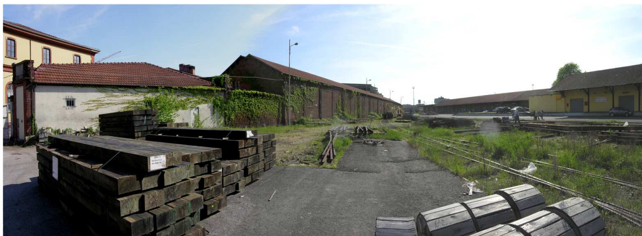
Vista dei capannoni in disuso verso sud
