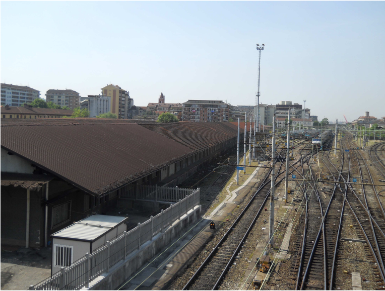
vista binari ferroviari e capannone dal cavalcavia
