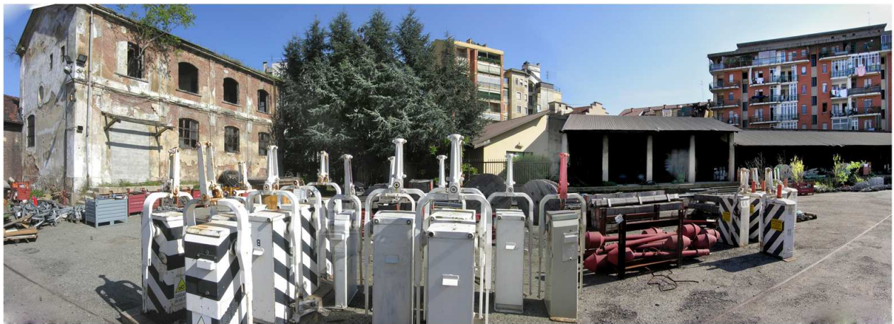
Vista di edifici e capannoni in disuso
