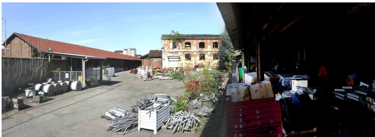
Vista di edifici e capannoni in disuso
