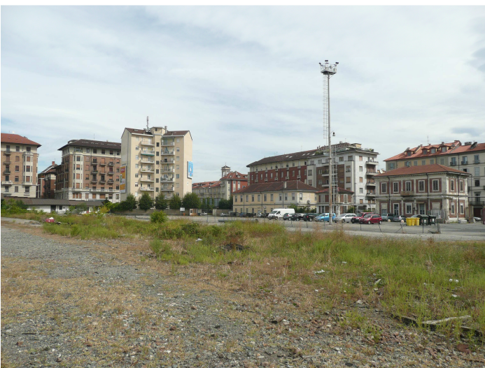
Area con piazzale, retro edificio corso Sommeiller angolo via Nizza e edifici minori tutelati
